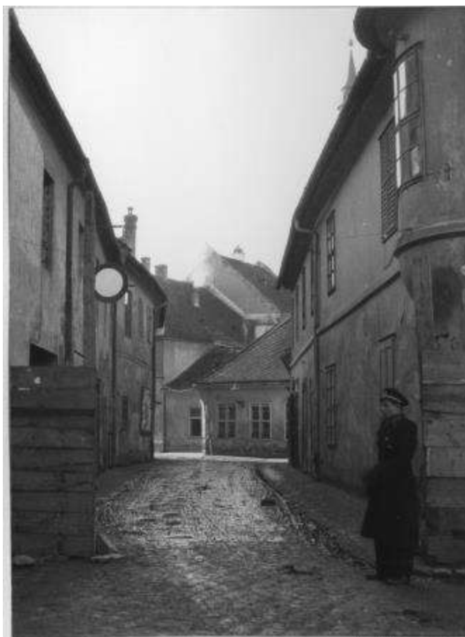
Hornopotočná ul. zaniknuté vyústenie do Trojičného nám. od Pekárskej pred 1949
