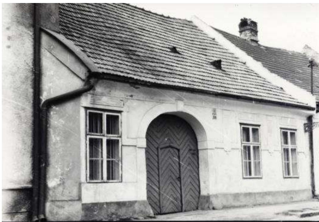
Františkánska ul., dom v západnej uličnej fronte
