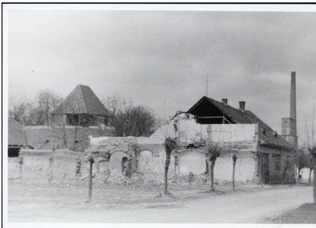
Františkánska ul., západná strana - búranie 70. r. 20. st.
