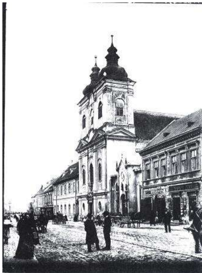
Štefánikova ul. juhozápadná časť, 10. r. 20. st.
