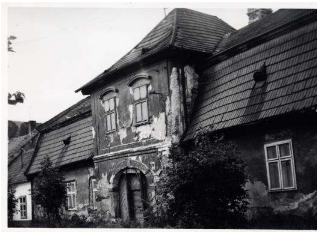
Františkánska ul., dom v západnej uličnej fronte, 1962
