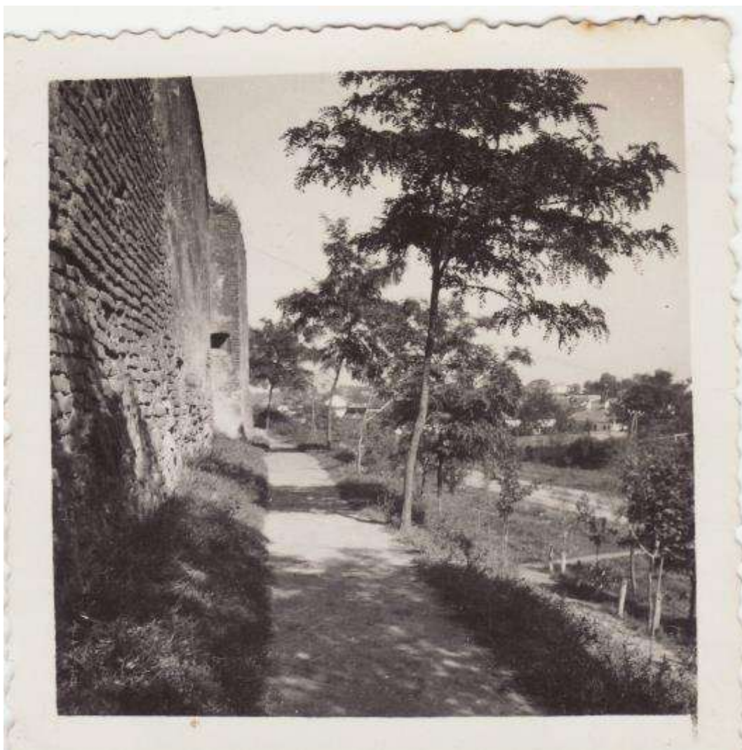
hradby, južná část východného úseku, zač. 20. st.
