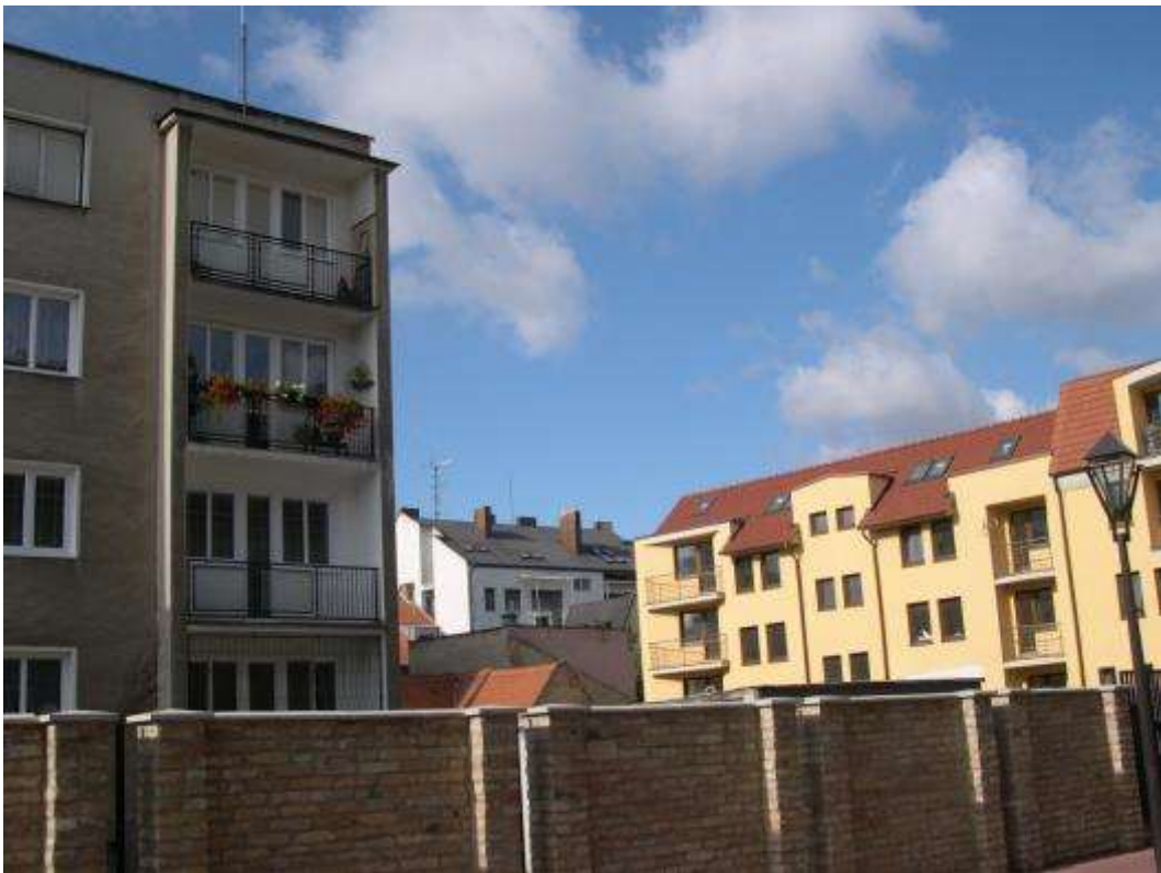
Veselá ulica 3 - obytný dom
