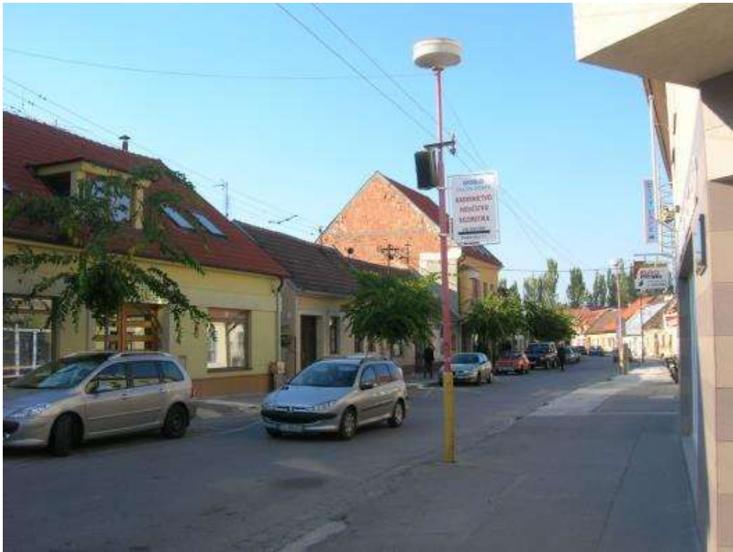
Pekárska ulica - pohľad od juhu
