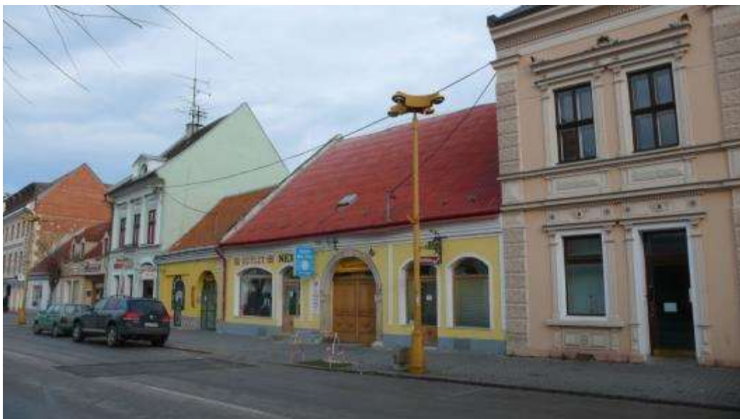
Štefánikova ulica - pohľad na SV časť
