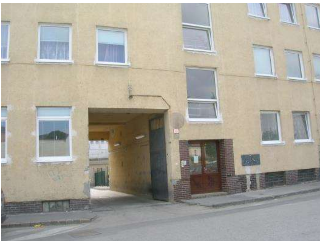
Pekárska ulica 41, 42 - pošta
