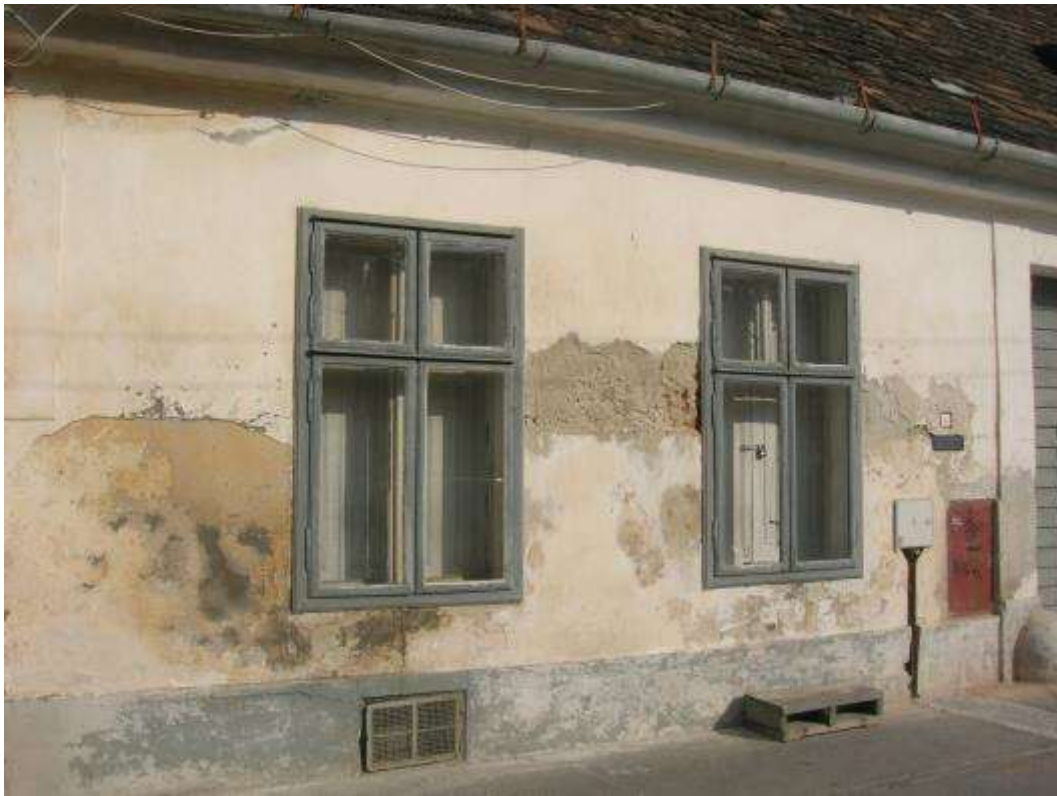
Pekárska ulica 13 - okná
