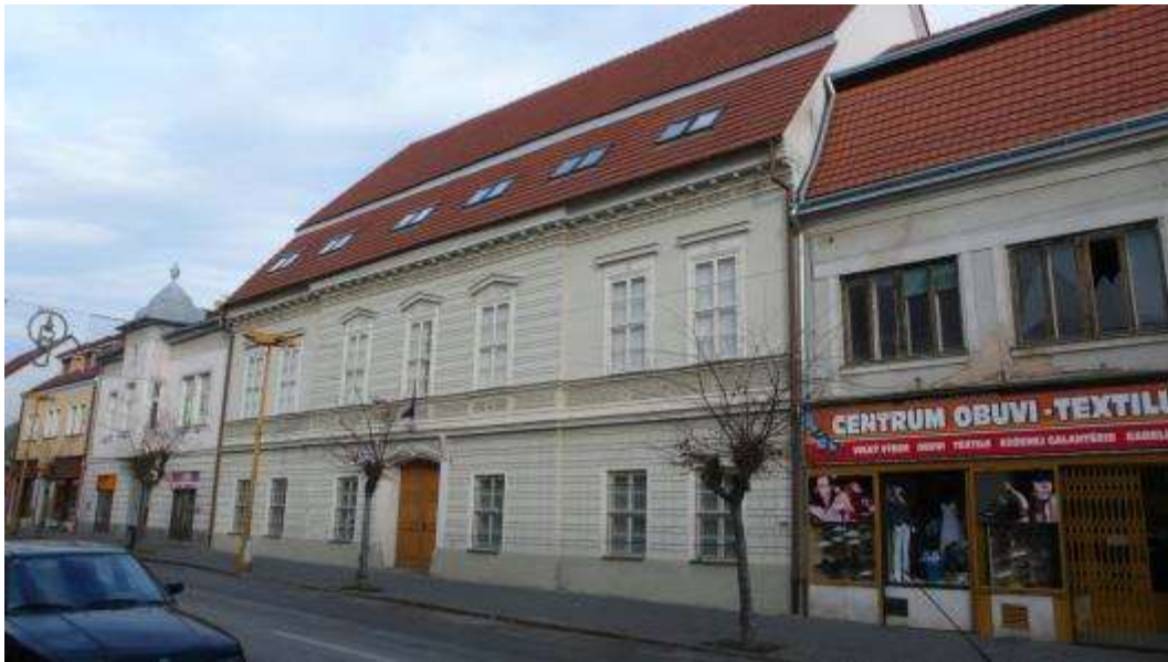
Štefánikova ulica 7 - objekt v zástavbe
