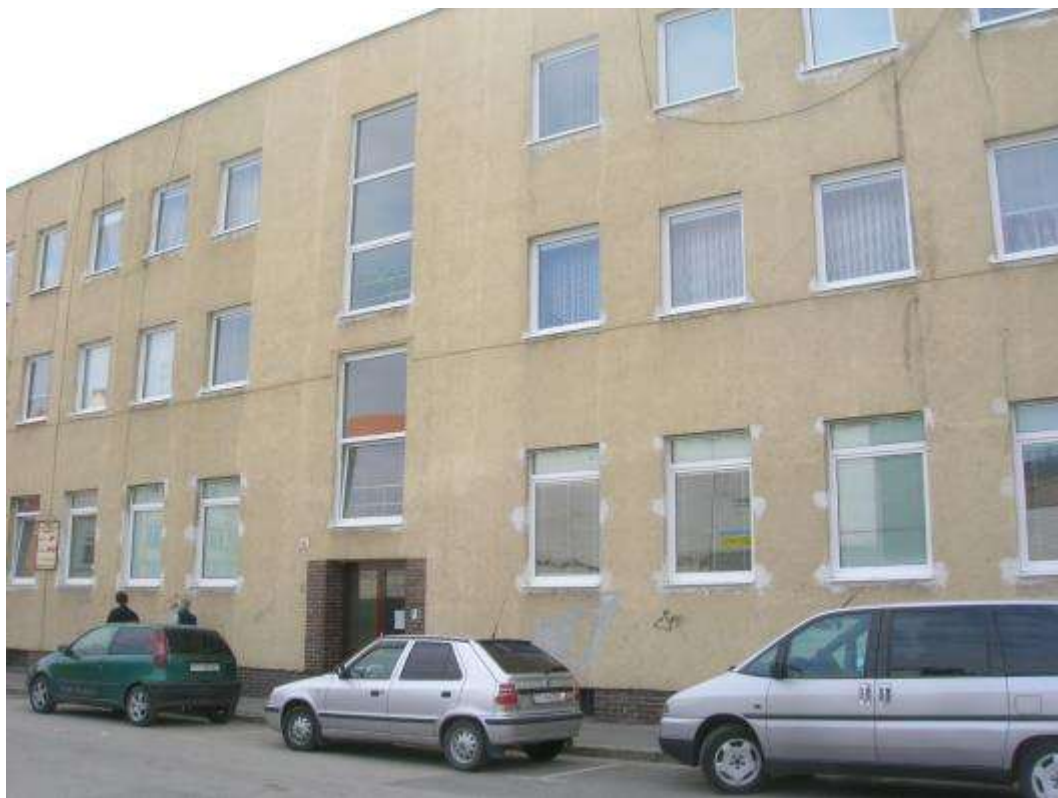
Pekárska ulica 41, 42 - pošta
