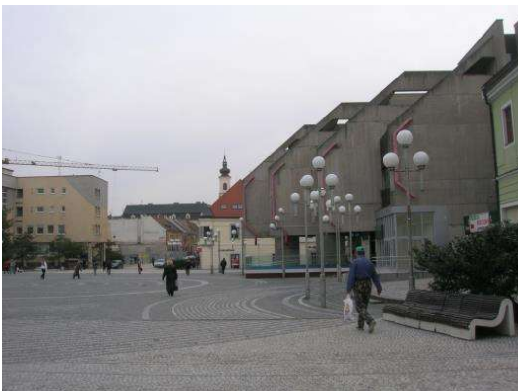
Trojčné námestie - pohľad na časť Trojičného námestia s rušivými hmotami
