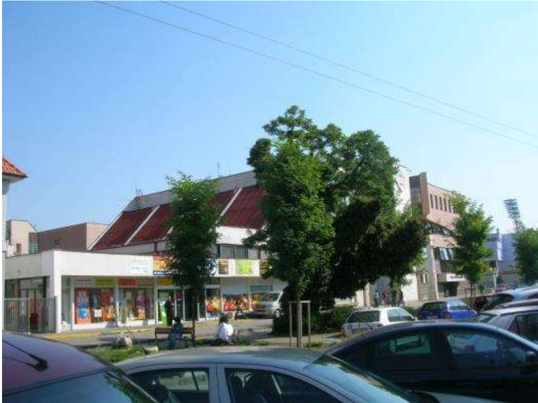
Paulínska ulica 17 - východná strana
