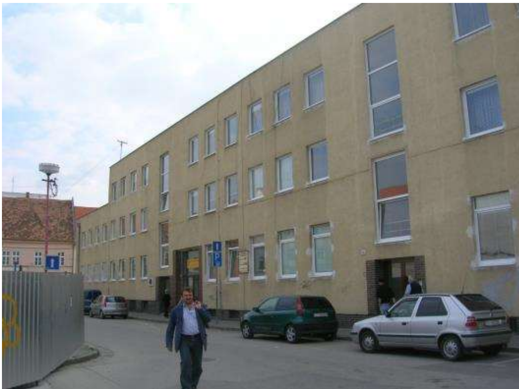
Pekárska ulica – Pošta
