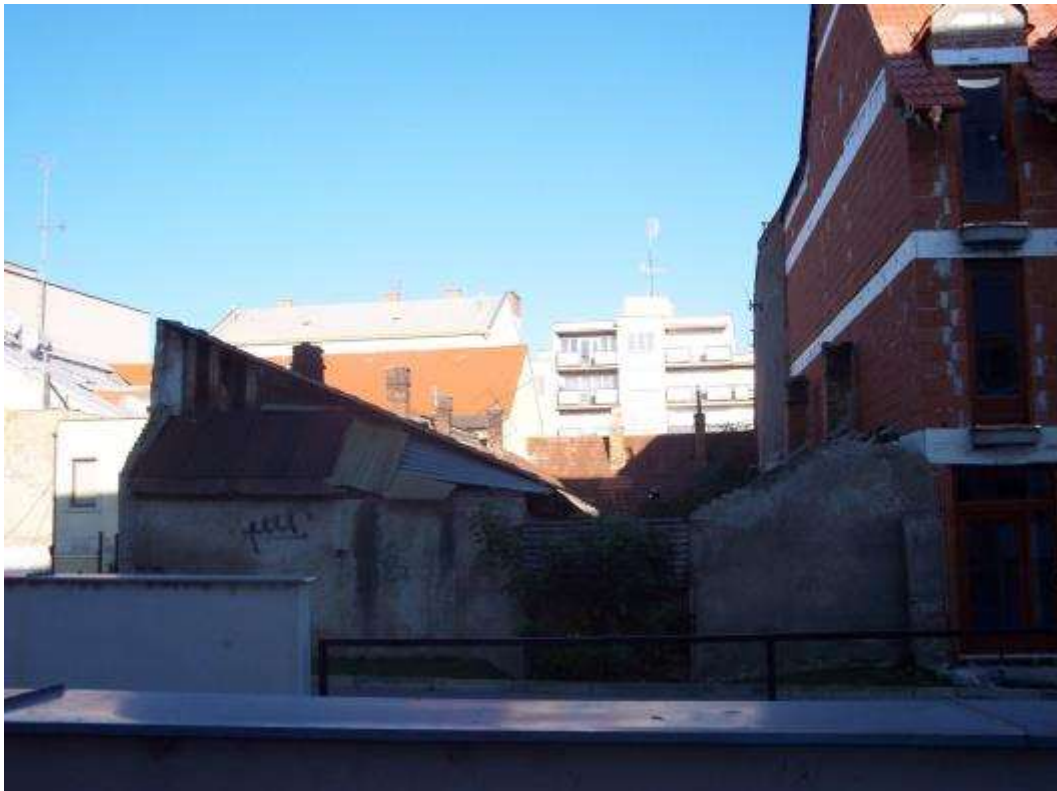
Vajanského ulica - pohľad na Hlavnú cez zástavbu
