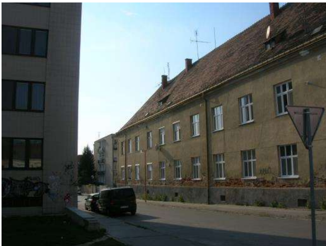
Veselá ulica - Kláštor paulínov a Veselá 3 obytný dom
