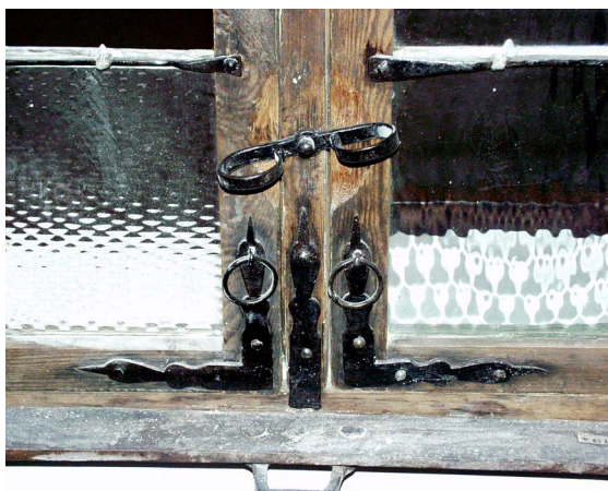
► Obr. 7. Detail okna s obrtlíkom, kyvným kruhom na očku a stužujúcim rohovníkom, kláštor Rádu svätej Uršule, Bratislava.
