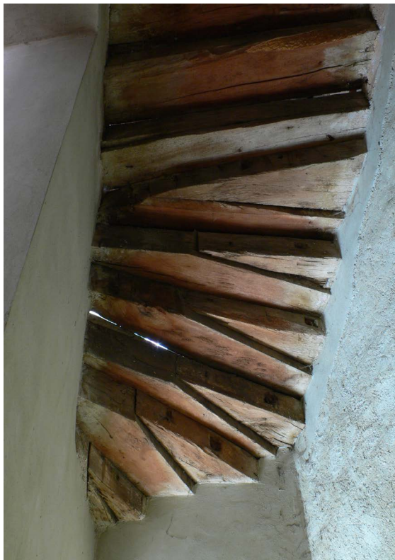
►► Obr. 12. Schodisko z tvrdého dreva, ktoré je zložené z plných drevených stupňov, stupne sú zo spodnej strany zošikmené a podstupnica je upravená profilovaním, meštiansky dom, Štiavnické Bane.
