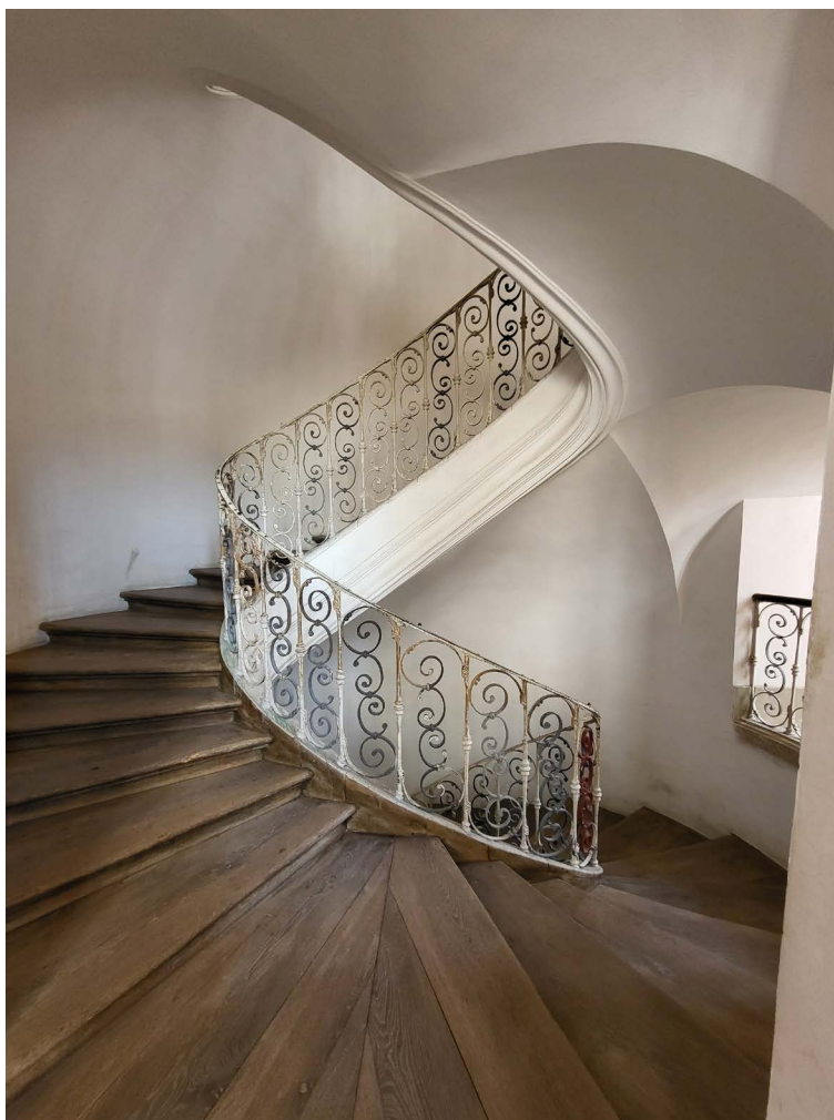
► Obr. 38. Drevené točité schodisko s kovaným zábradlím, kláštor, Plasy.
