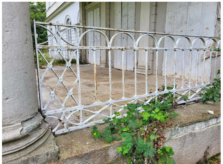
► Obr. 34. Dekoratívne kovové zábradlie z prútov obdĺžnikového prierezu, kaštieľ, Tajná.
