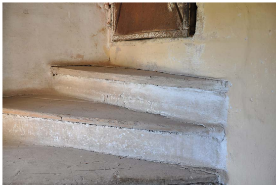
► Obr. 3. Murované stupne schodiska s omietanou podstupnicou a doskovou nástupnicou, meštiansky dom, Štiavnické Bane.
