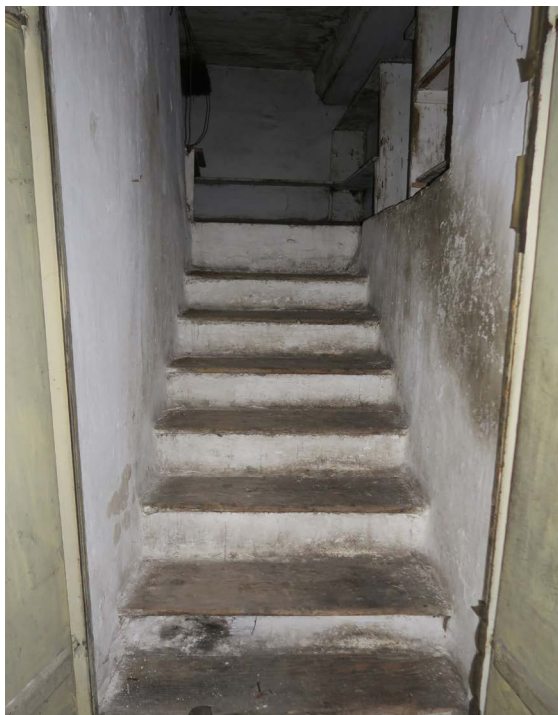
►► Obr. 5. Zalomené schodisko do podkrovia, spodné rameno je z kamenných stupňov (podmurovaných) s reliéfne upravenou bočnou stranou, v hornej časti pokračuje drevené schodiskové rameno s doskovým podbitím, meštiansky dom, Banská Štiavnica.
