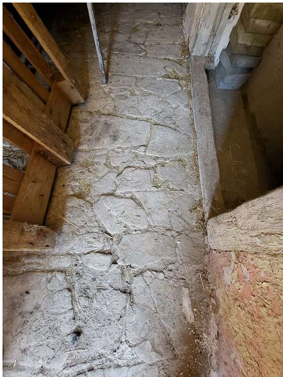
►► Obr. 7. Kamenná dlažba zo solnhofenského vápenca ukladaná do geometrického vzoru, meštiansky dom, Banská Štiavnica.
