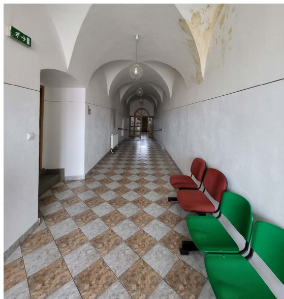
► Obr. 19. Novodobé keramické dlažby vo vstupných priestoroch objektu, Konvent, Brezno.
