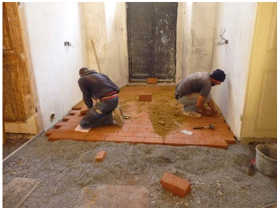
► Obr. 34. Ukladanie novej tehlovej dlažby (ostro pálenej) v prejazde, Kozelník.
