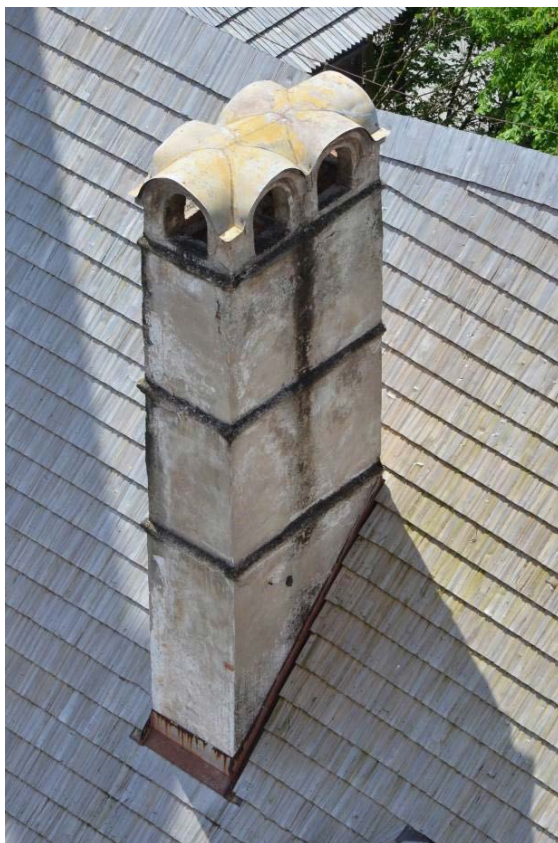
► Obr. 5. Oravský hrad, komínová hlavica ukončená tehlovými klenbami prekrytými plechom.
