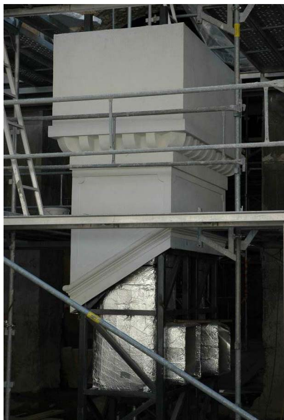
► Obr. 20, 21. Bratislavský hrad, kompletizácia vzduchotechniky, komínových plášťov a hlavíc pred osadením na strechu, 2009.
