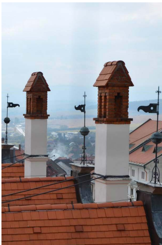
►► Obr. 8. Svätý Anton, hlavica nefunkčného komína uzatvorená plechom.
